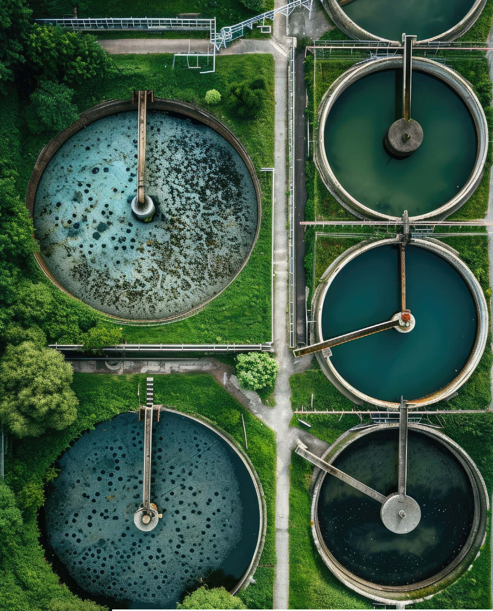
Ausrüstung von Wasseraufbereitungsanlagen
